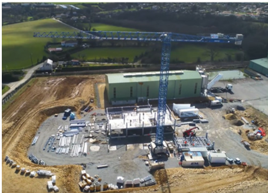
Construction de l'unité de trituration sur le site de la SICA ALICOOP Pamproux - mars 2025
