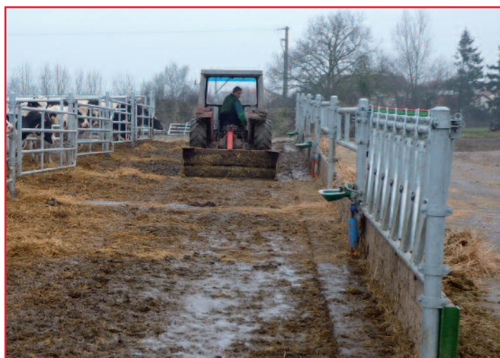
Photo 7 : PSH avec un sol en enrobé, nettoyé 3 fois par semaine (y compris la zone de couchage). Le marchepied et l'auge sont en béton. Les autres poteaux ont été implantés dans un plot en béton et sont protégés à la base par un tube PVC de 20 cm de hauteur afin de réaliser un joint d'étanchéité.
