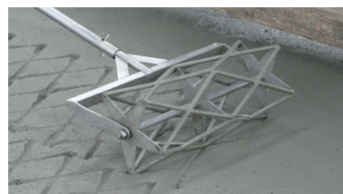
Photo 9 : Béton avec finition empreintes
