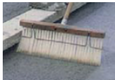
Photo 8 : Béton avec finition balayée
