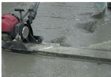
Photo 6 : Béton tiré à la règle
