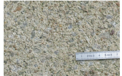
Photo 16 : Béton de sol désactivé
