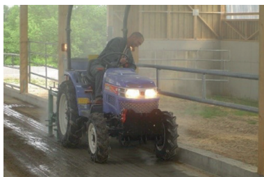
Photo 13 : Rainurage de béton
