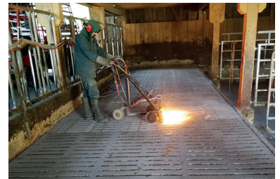
Photo 15 : Opération de scarification
