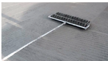
Photo 7 : Béton avec finition au rouleau « Roller Tamper » ou rouleau Lissarde
