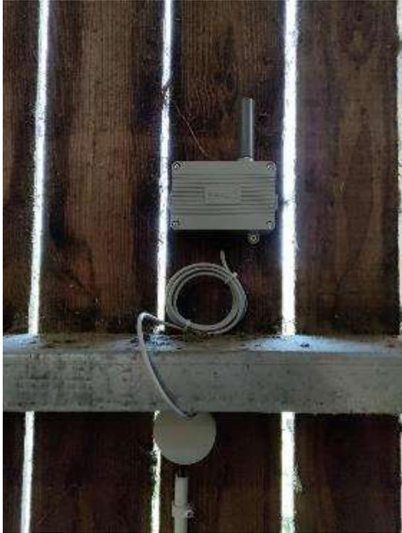
Figure 2 : Compteur d'eau à impulsion
