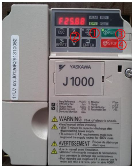
Photo 12 : Commande du variateur de fréquence de la pompe à vide
