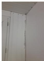
Présence de moisissures au niveau d'un pont thermique
