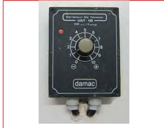
Photo 14 : variateur de vitesse permettant de faire varier la vitesse de rotation des ventilateurs sur la batterie froide, permettant de faire varier leur débit et ainsi agir sur le taux de brassage de l'air en fonction de la charge du hâloir Source : M. Teinturier, FRESYCA
