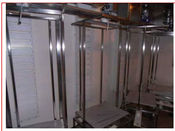
Photos 17 et 18 : gaine plastique de soufflage d'air dans un séchoir tournant (en blanc à gauche de la photo) Source : S. Morge, PEP caprin Rhône-Alpes
