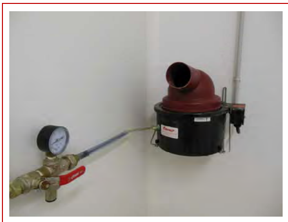
Photos 11 et 12 : différents modèles d'humidificateurs externes à l'évaporateur dans un hâloir Source : A. Chabanon, FRESYCA et C. Reynaud, Actalia-Produits Laitiers
