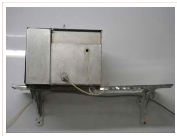
Photos 11 et 12 : différents modèles d'humidificateurs externes à l'évaporateur dans un hâloir Source : A. Chabanon, FRESYCA et C. Reynaud, Actalia-Produits Laitiers
