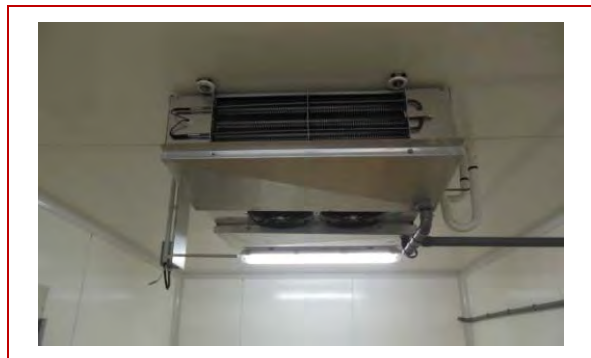
Photos 3 et 4 : évaporateur à détente directe dynamique Source : M. Pétrier, CTFC
