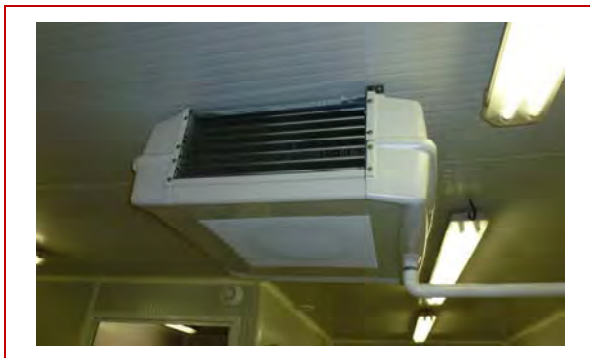
Photos 3 et 4 : évaporateur à détente directe dynamique Source : M. Pétrier, CTFC
