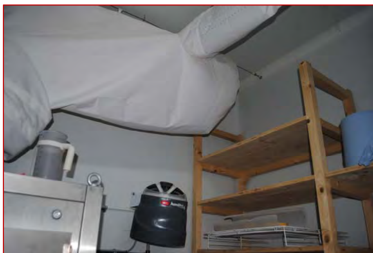
Photo 16 : gaine textile de soufflage de l'air dans une cave PPNC Source : S. Raynaud, Institut de l'Élevage
