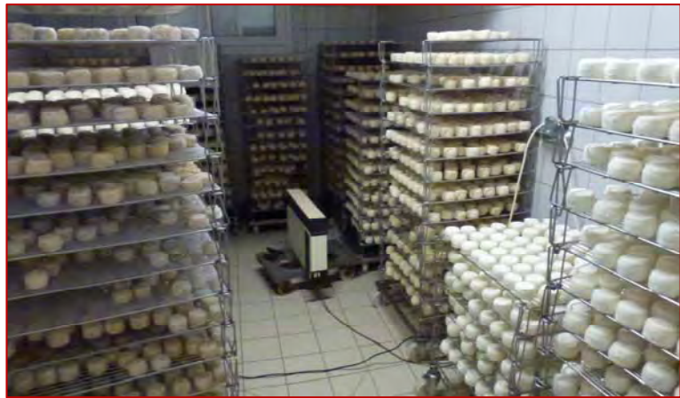
Photo 9 : radiateur d'appoint dans un hâloir – Source : M. Pétrier, CTFC
