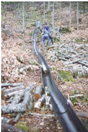
Photo 3 : vidange des bois grâce aux goulottes.
