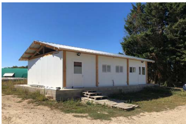
Photo 18 : Fromagerie en panneaux sandwich avant bardage bois
