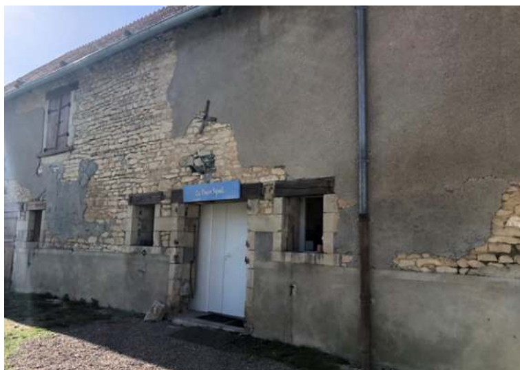
Photo 20 : Fromagerie en panneaux sandwichs dans un ancien bâtiment
