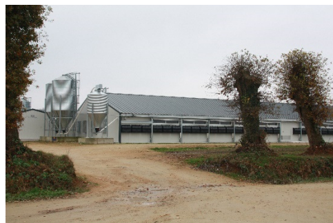
Figure 12 Prise de vue extérieure d'un bâtiment
