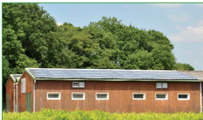
La centrale photovoltaïque du Rheu mise en service en mai 2013
