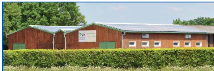
160 m 2 de panneaux photovoltaïques d'une puissance totale de 24 kWc
