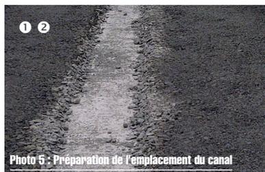
Photo 5 : Préparation de l'emplacement du canal
