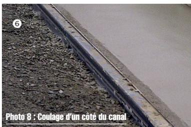
Photo 8 : Coulage d'un côté du canal
