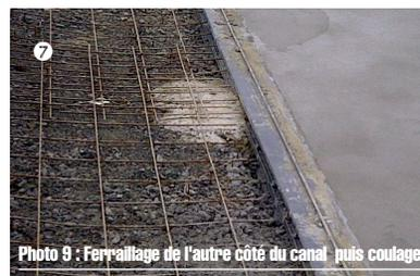
Photo 9 : Ferrailage de l'autre côté du canal puis coulage
