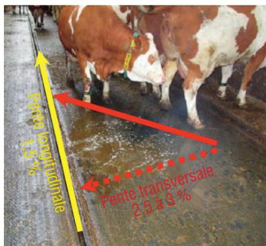
Photo 4 : Pentes longitudinales et transversales recommandées
