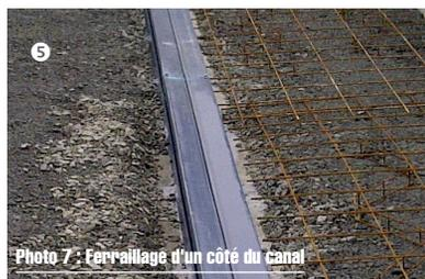
Photo 7 : Ferrailage d'un côté du canal
